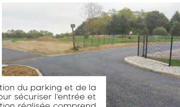
2022 a vu aussi la réalisation du parking et de la route autour de l'école pour sécuriser l'entrée et la sortie scolaire. L'opération réalisée comprend la création de places de parking perméables en englobant le traitement des eaux (mise en place de casiers tampons) de surface et ruissellement de l'allée de Begards.
